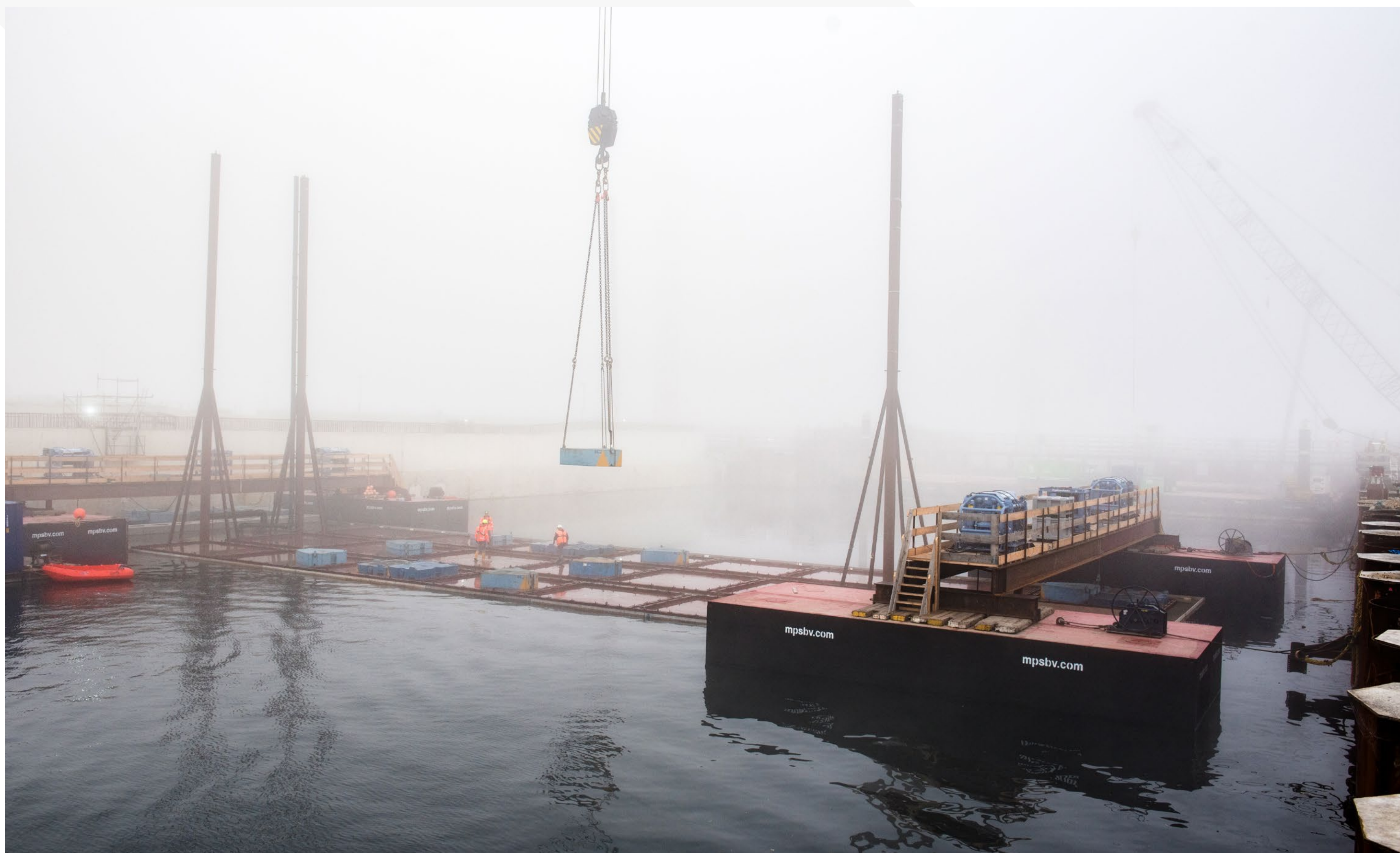
© Foto Nieuwe Sluis Terneuzen
