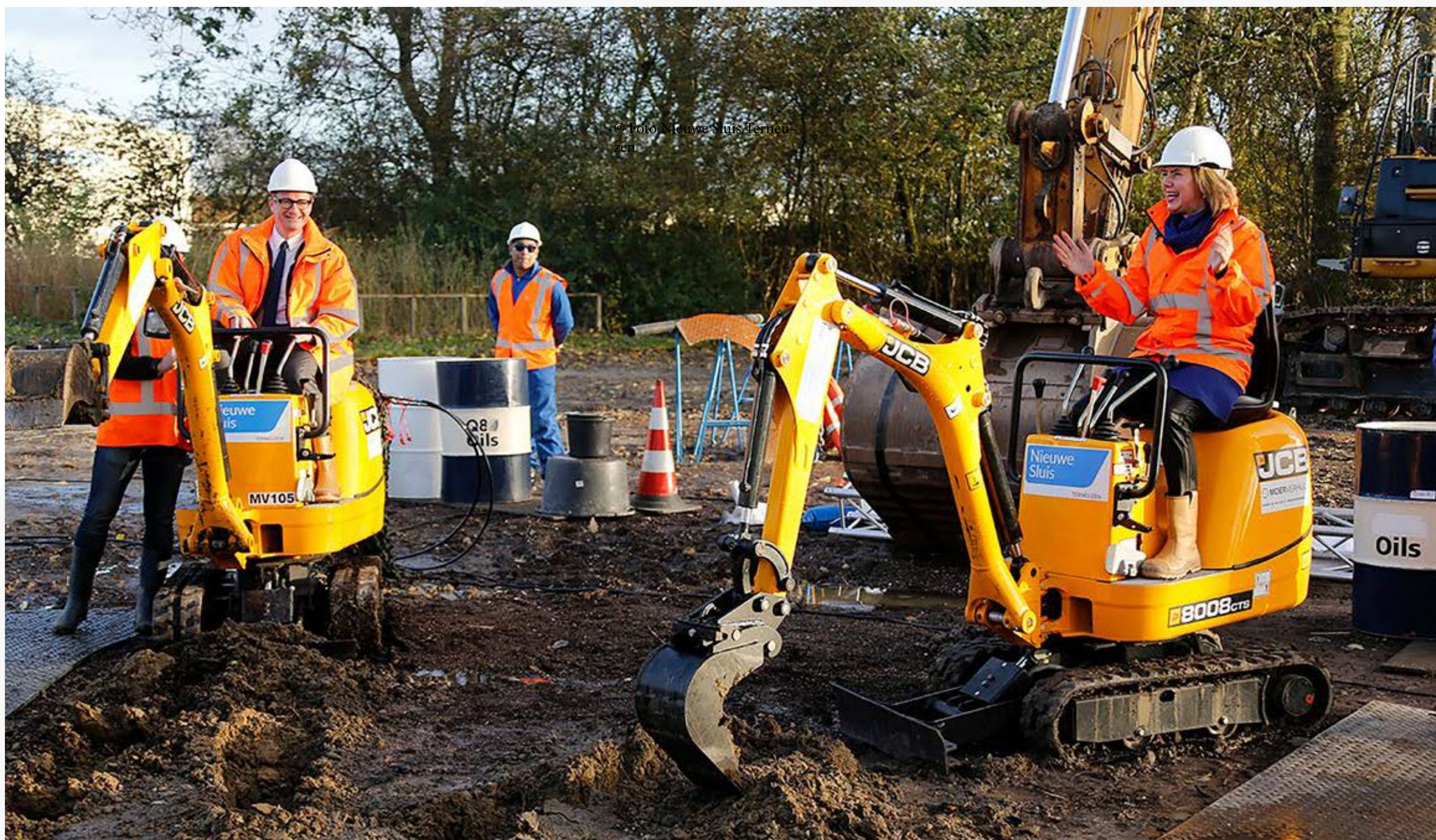
© Foto Nieuwe Sluis Terneuzen
