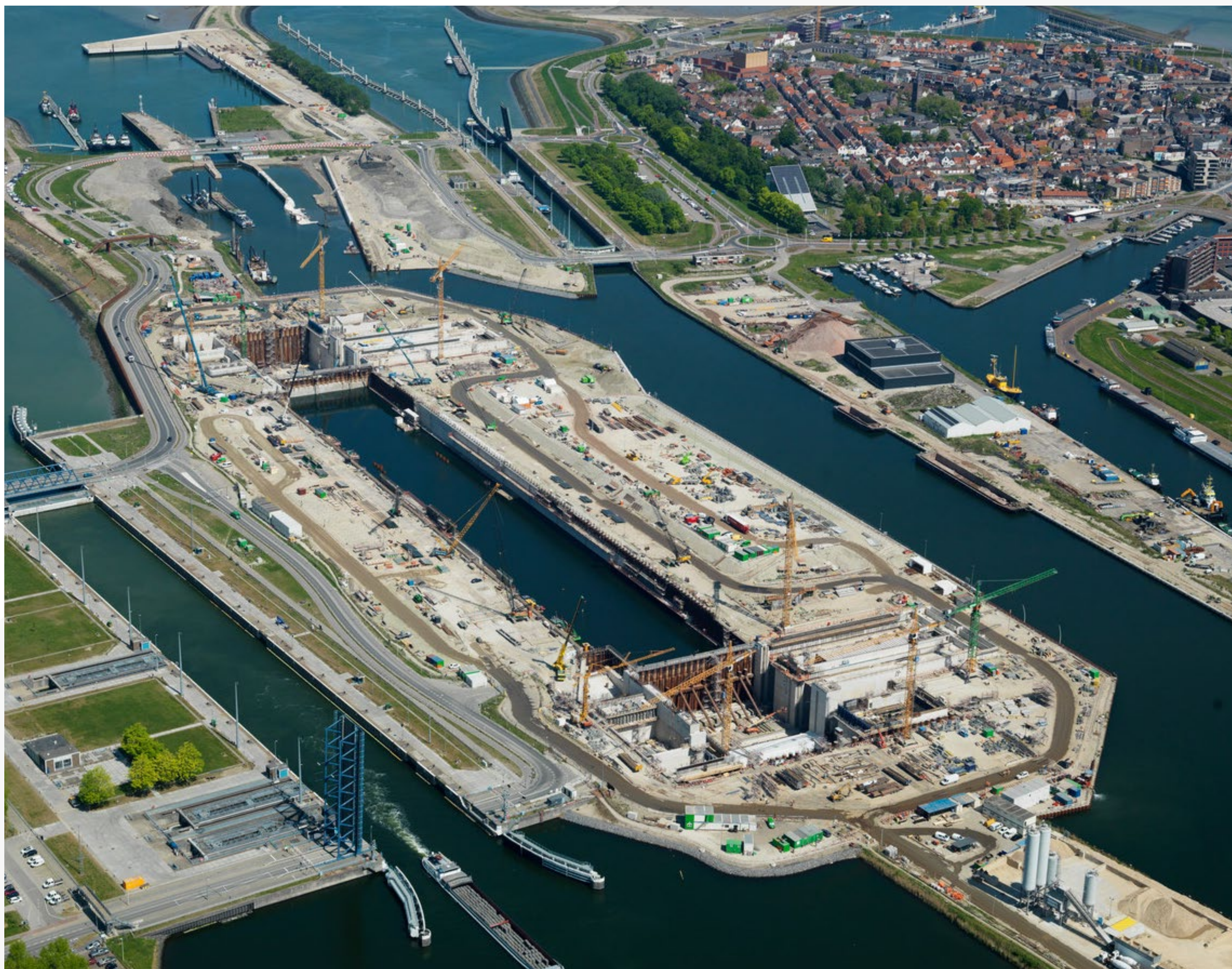
© Foto Nieuwe Sluis Terneuzen
