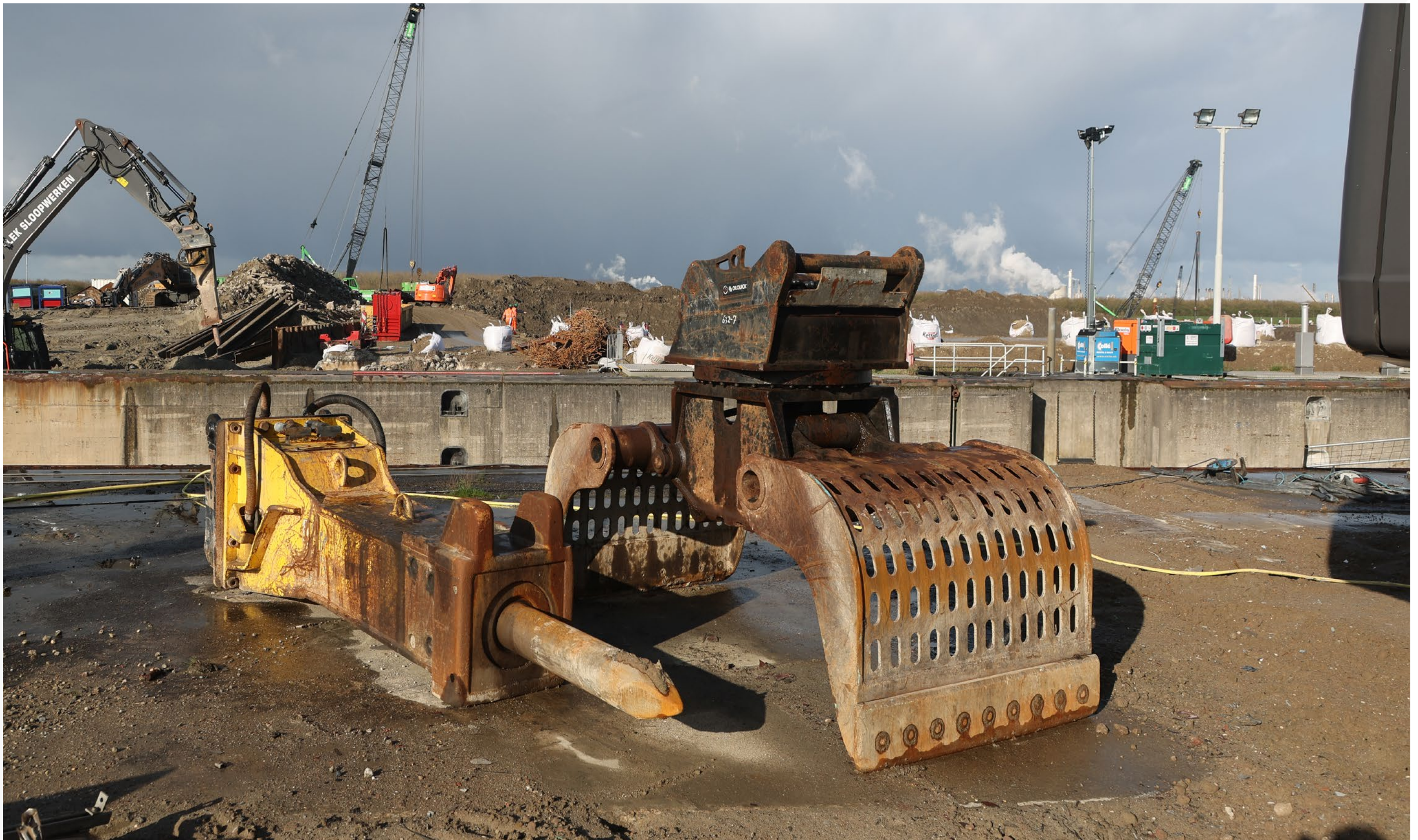
© Foto Nieuwe Sluis Terneuzen
