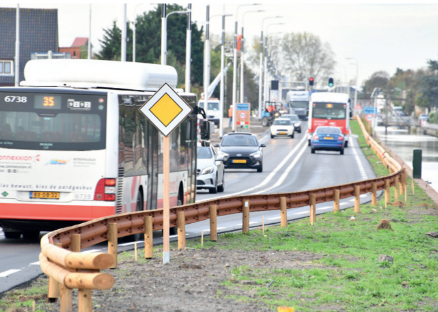
De energiepositieve en CO 2 -negatieve N211c tussen Den Haag en Poeldijk (bron: BAM)
