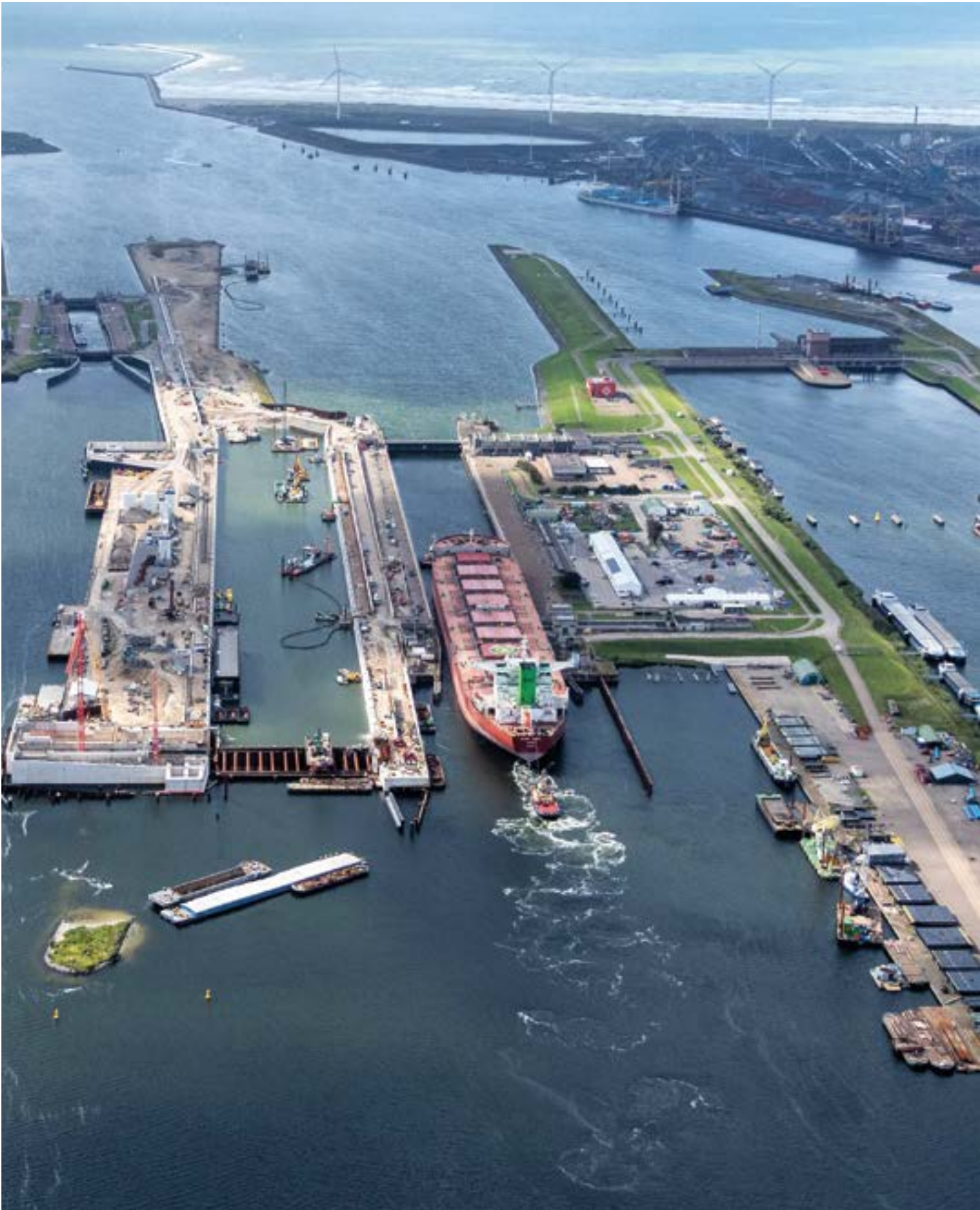
Zeesluis IJmuiden (the Netherlands) - BAM Infra Nederland
